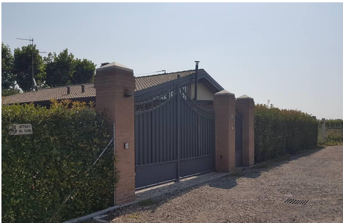
Foto 59 – Accessibilità Rurale Lovoletto
