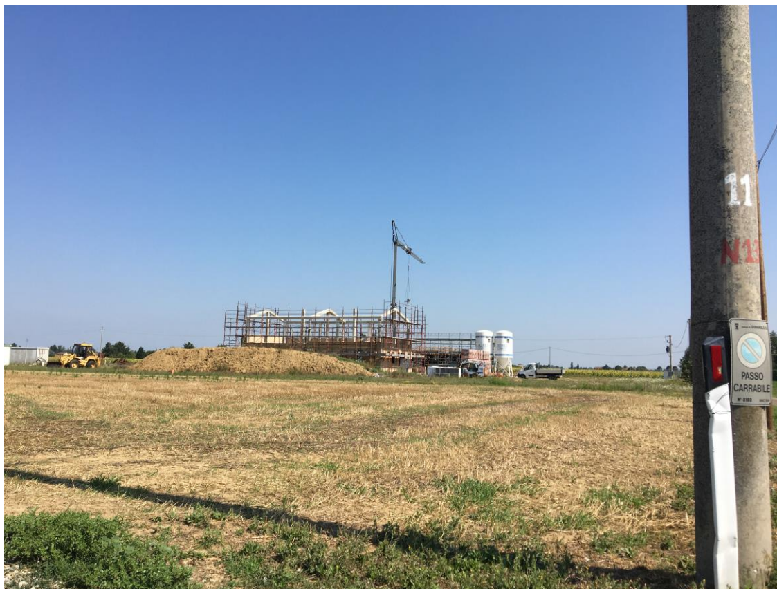
Foto 50 – Vista lotti in costruzione su via Ballina
