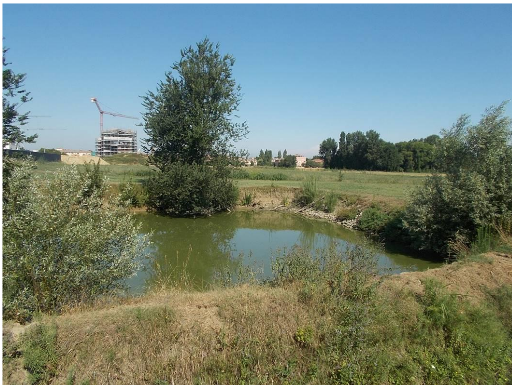
Foto 19 - Vasca di laminazione a servizio del Sub-ambito 3.5
