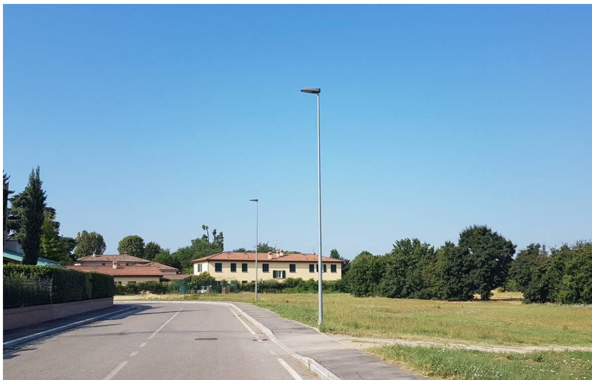
Foto 64 – Accessibilità Ambito C 2.6
