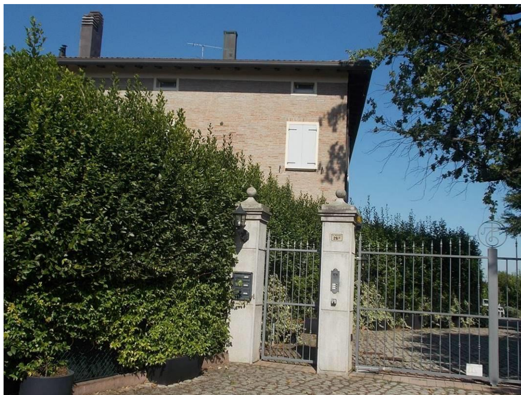
Foto 45 - Accesso via Ghiaradino
