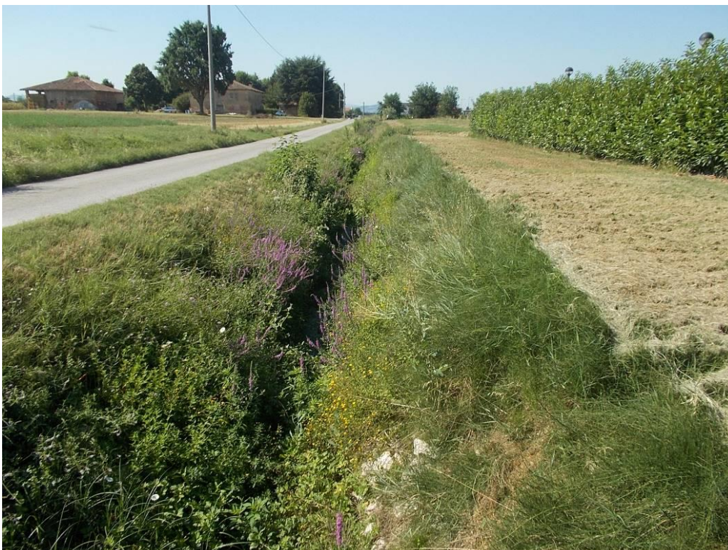
Foto 21 – Canale di scolo via Ballina
