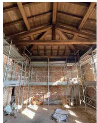
sostenibili e performanti: cappotto interno in lana di roccia da 14 cm, tetto coibentato e impianto termico completamente elettrico alimentato da pompa di calore. I nuovi serramenti assicurano un importante miglioramento dell'efficienza energetica complessiva, senza alterare l'aspetto originario della struttura.
